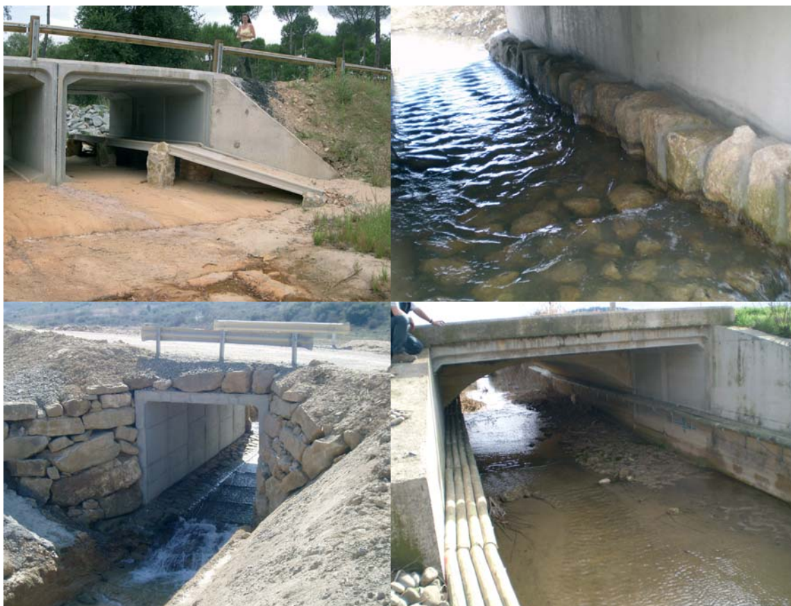
Arriba a la izquierda, plataforma lateral y rampa secas prefabricadas de hormigón, y conexión con orilla (LIFE-LINCE Andalucía). A la derecha, plataforma lateral depiedra de escollera, Falces (LIFE-GERVE). Abajo a la izquierda, plataforma lateral de encachado de piedra. Barranco de la Torre, Mérida (LIFE-GERVE). Derecha: Repisas laterales de madera tratada. Val del Rey, Carcastillo (LIFE-GERVE).
