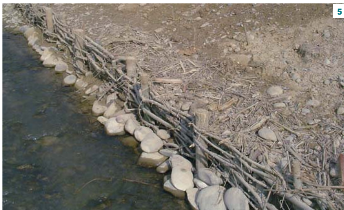
Estabilización de orilla mediante escollera (1). Estabilización de orilla mediante krainer (2) Estabilización de orilla mediante cobertura de ramas (3) (LIFE-GERVE Carcastillo). Estabilización de orilla mediante fajinas (4) (LIFE-GERVE Carcastillo). Estabilización de orilla mediante entramado vivo (5) (LIFE-GERVE Carcastillo).
