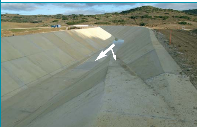
Rampa de salida para la fauna silvestre en el Canal de Navarra. A la derecha, esquemas de rampa de salida.
