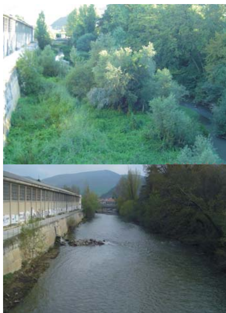
“Limpieza” de cauce en el río Arga (antes y después).
