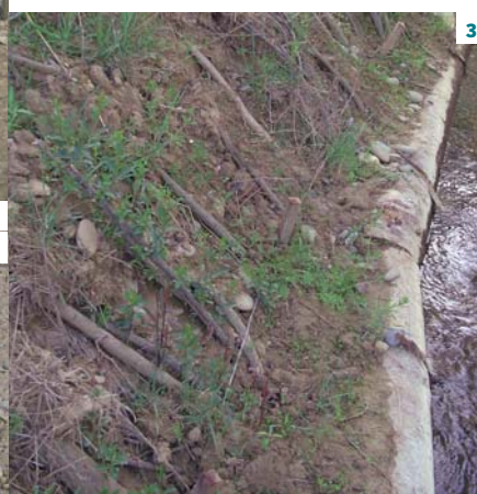
Estabilización de orilla mediante escollera (1). Estabilización de orilla mediante krainer (2) Estabilización de orilla mediante cobertura de ramas (3) (LIFE-GERVE Carcastillo). Estabilización de orilla mediante fajinas (4) (LIFE-GERVE Carcastillo). Estabilización de orilla mediante entramado vivo (5) (LIFE-GERVE Carcastillo).
