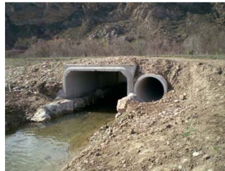
Combinación de marco con repisa y tubo lateral seco en “Sotoabajo”, Falces. Fase de obra (LIFE-GERVE).
