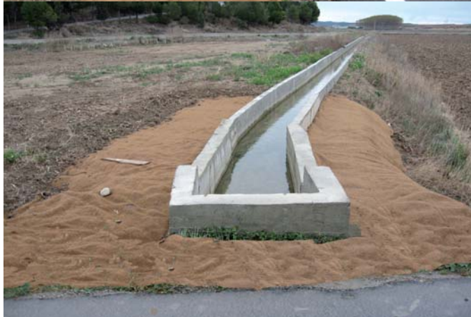
Eliminación de vegetación en intersecciones entre acequias y carreteras. Aplicación de hormigón y colocación de geotextil antihierbas.
